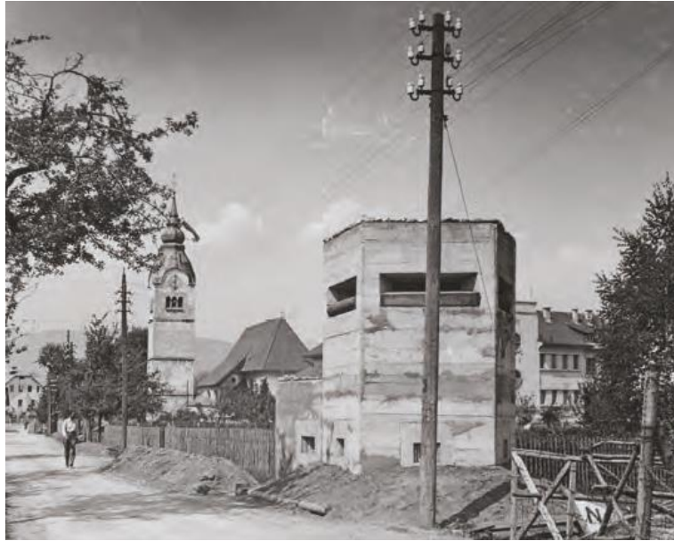
Bunker pred šolo v Lescah, 1941-45 Vir: Nemci in partizani (GM Kranj – GkiL št. 39)
