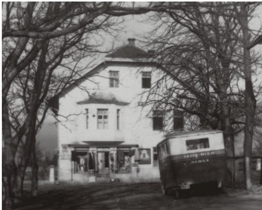
Trgovina z mešanim blagom Jeglič, od. 1942 Vir: DAR (detajl)
