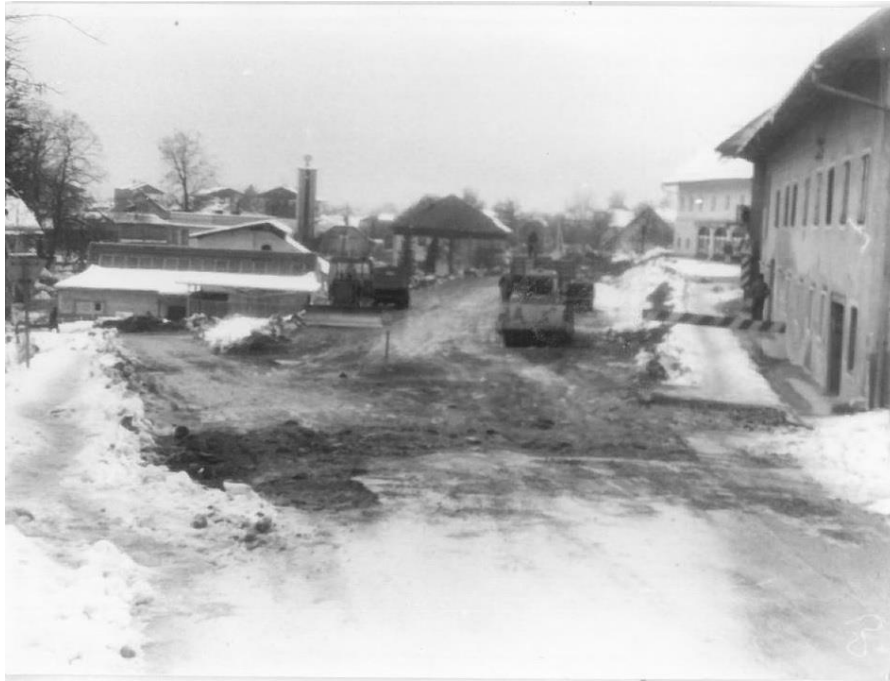
Gradnja novega križišča, 1985 Vir: arhiv KS Lesce
