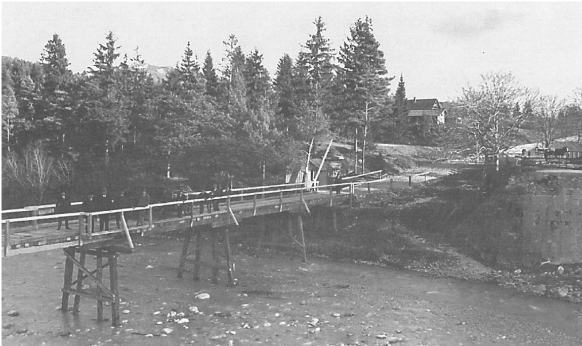
Obnavljanje mostu preko Save, 1926 Vir: Leški zbornik
